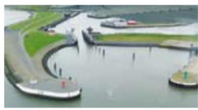
**5 SCHLEUSENANLAGE/MOLE** Die 22 m breite Hafeneinfahrt 1/E|F. Hier wird der ein- und ausfahrende Schiffsverkehr über Funk und Ampelanlage havarifrei gelenkt. Hauptsächlich dient die Anlage aber dem Hochwasserschutz, denn bei einem Wasserstand von 40 cm über dem normalen Hochwasser werden die Schleusentore geschlossen und der Schiffsverkehr wird geschleust. Auf beiden Seiten der Schleusenanlage ist je ein Leuchtfeuer (rot = Backbord/links, grün = Steuerbord/rechts).
